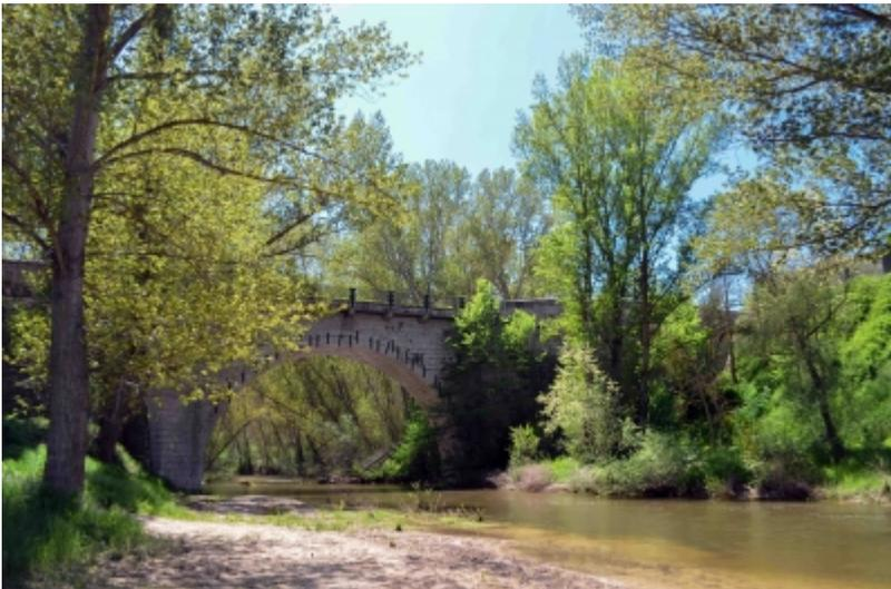
Es el existente sobre el río Eresma. De un solo ojo con arco de medio punto, construido en sillares de piedra caliza, con algunos tramos de manpostería de pizarras y material reaprovechado de otras construcciones. Las paredes en talud y contrafuertes, con un tajamar en ángulo. Levantado posiblemente sobre restos de otro romano que comunicaba ambas orillas urbanizadas, siendo la bajada de El Atajo por donde estaría trazada la calzada. Lo que hoy vemos empedrado no es otra cosa que su última
